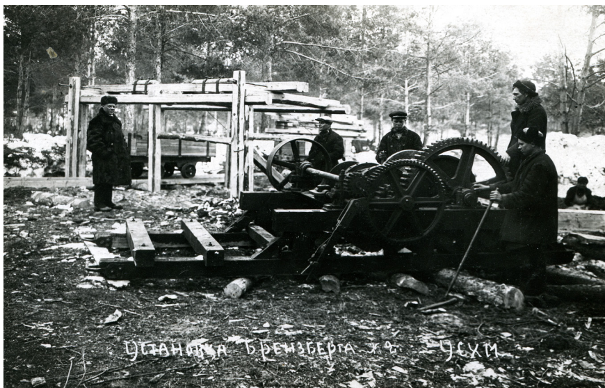
3. Установка Бремсберга № 2. Фото. Б. д. [Музей истории Уралхиммашзавода] Brake incline No. 2. Photograph. Undated
